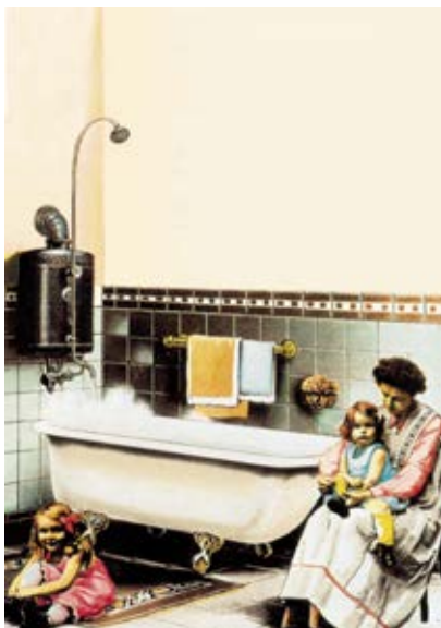
Plynový průtokový ohříváč vody (1931)
