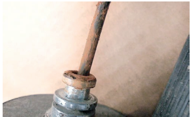
Korodirano i zategnuto kočiono užde
