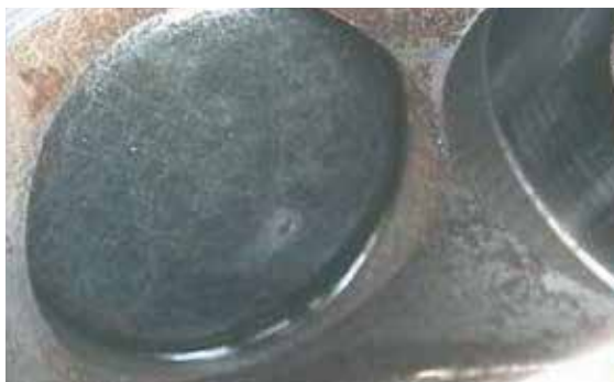
Korozija na kućištu visokotlačne pumpe
