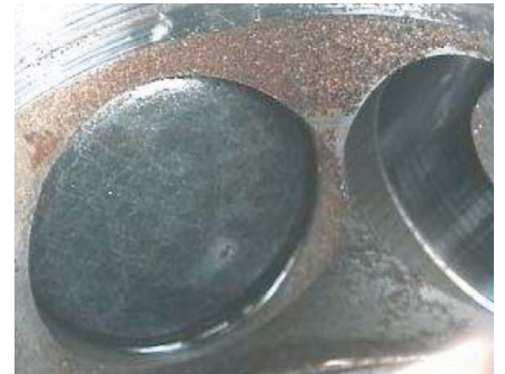
Korrózió a nagy nyomású szivattyú házán
