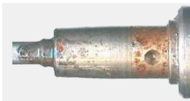
Corrosão no injetor
